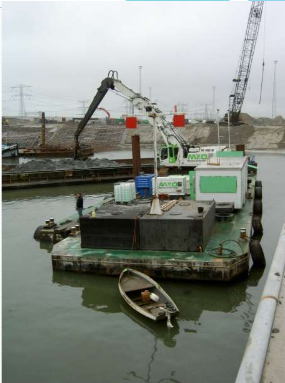
Werkponton (gekoppeld samenstel met baggerkraan)
