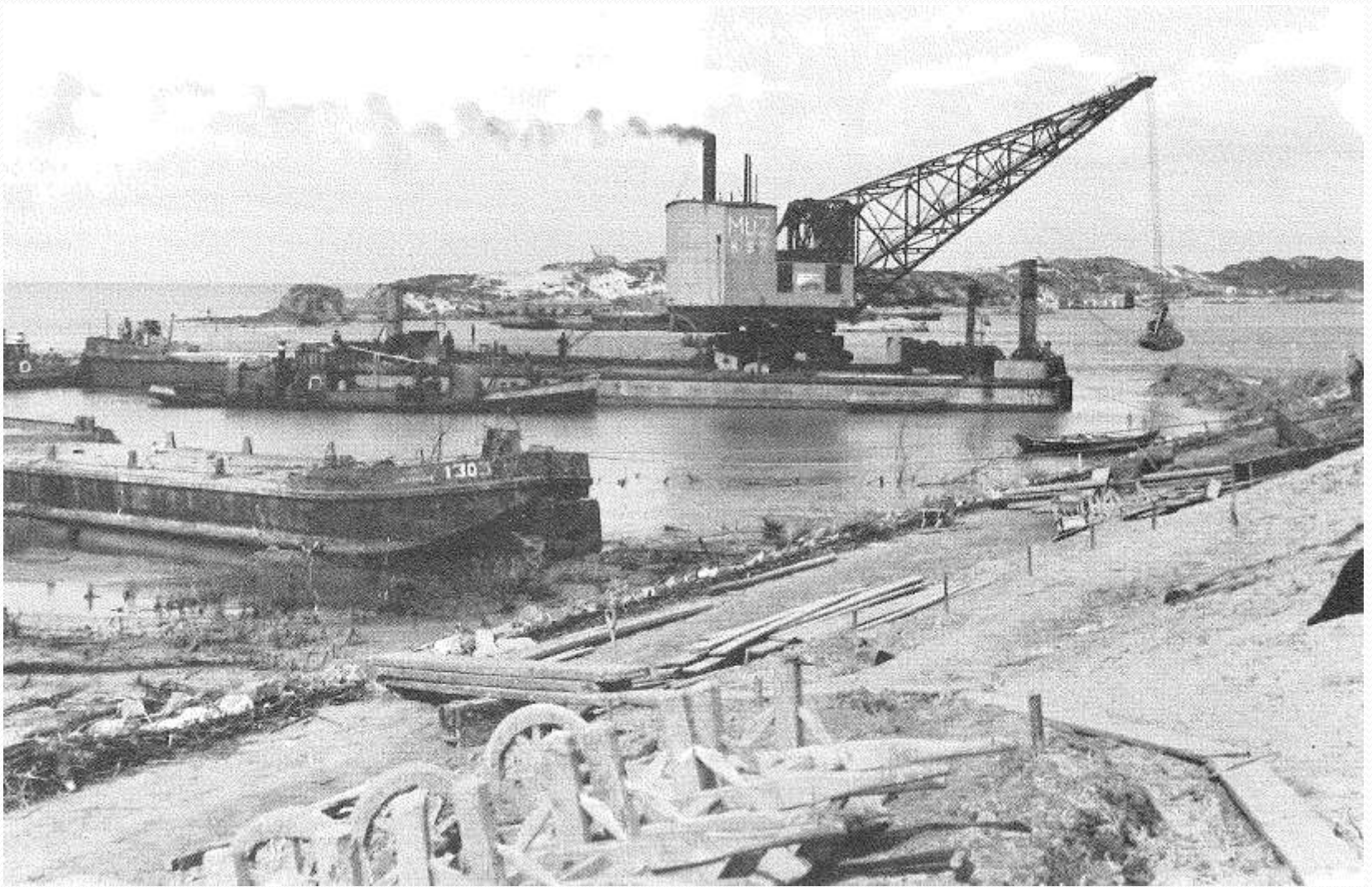
Aannemers aan het werk bij de afsluiting van de Nollendijk te Walcheren ca.1945
