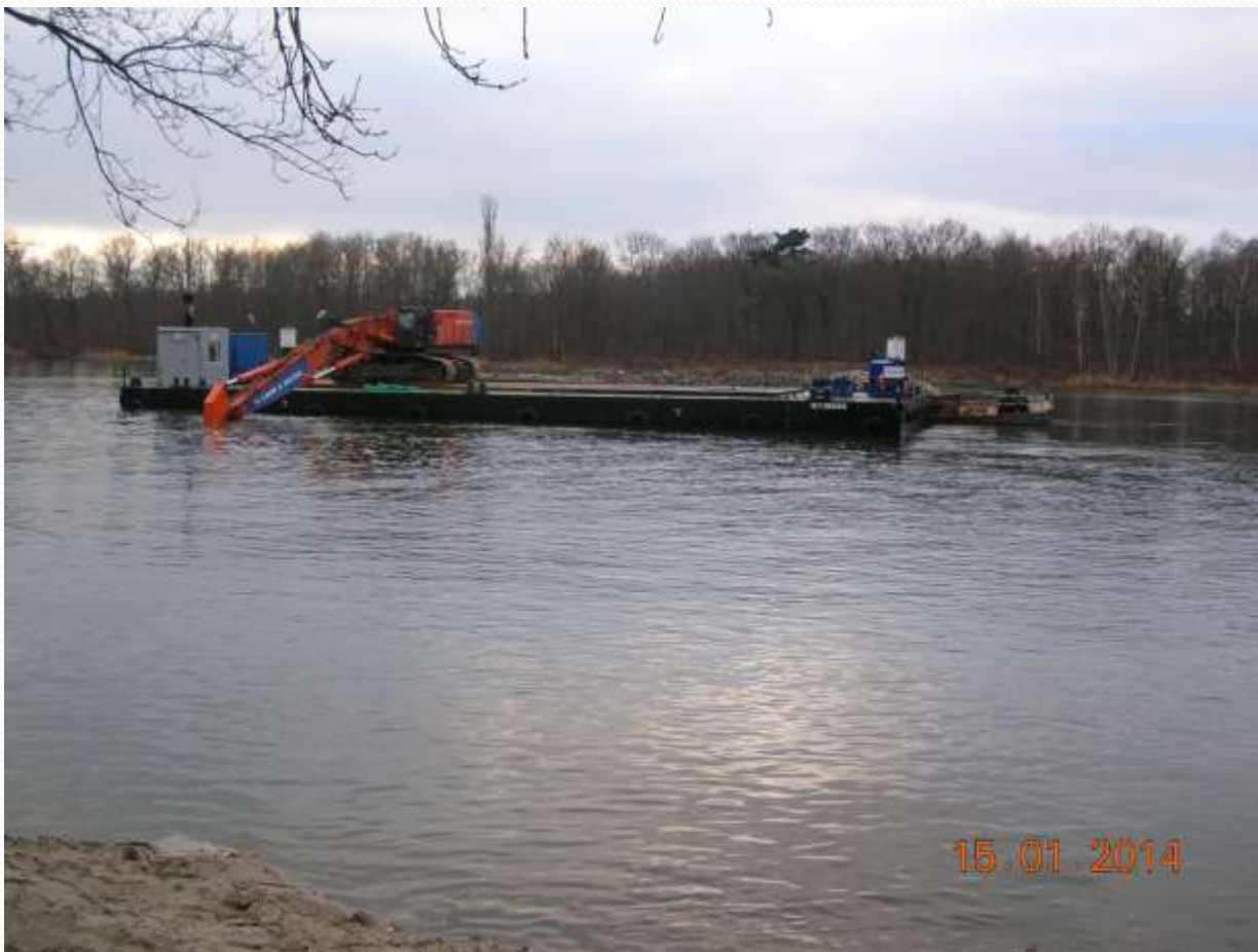
Werkponton met mobiele baggerkraan aan dek
