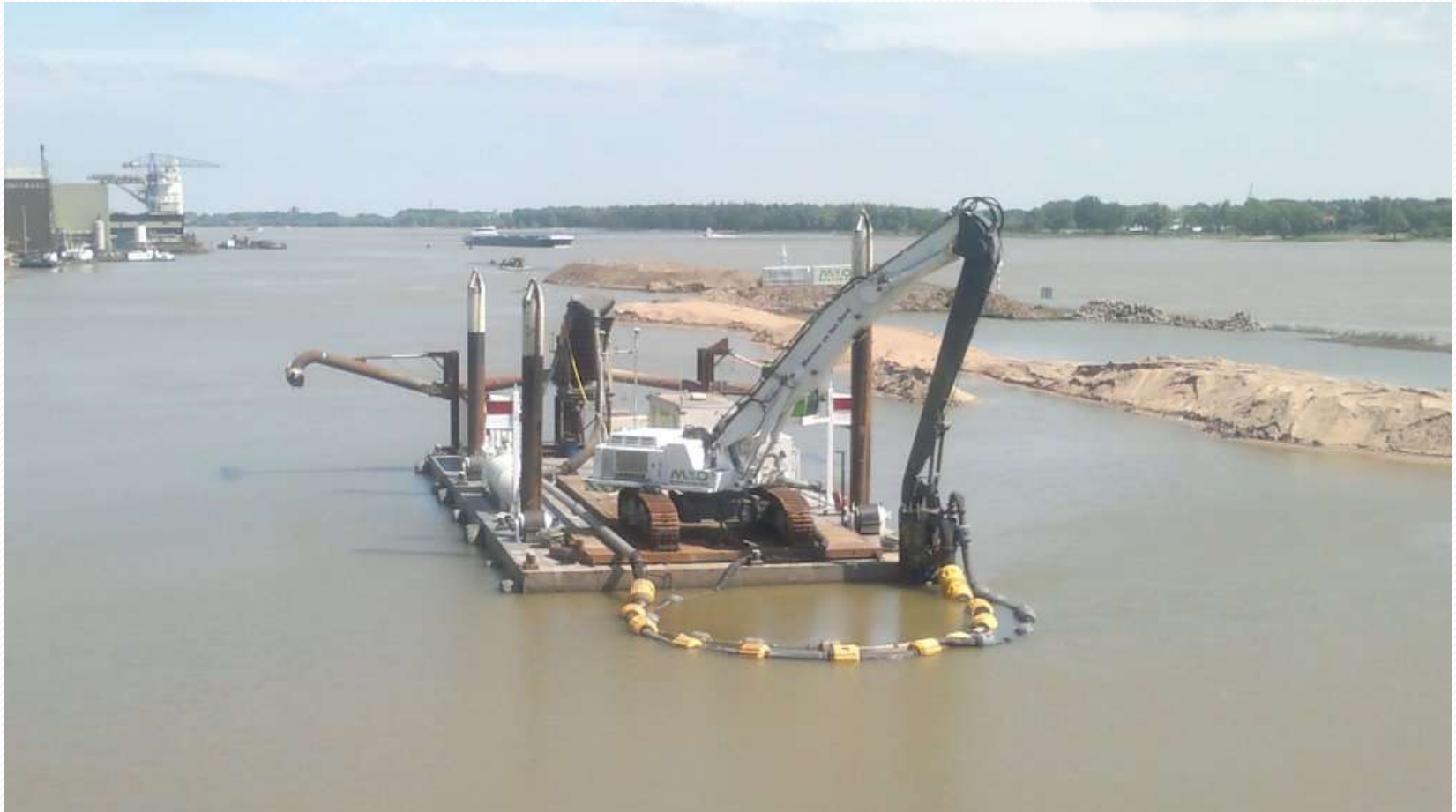
Werkponton met diverse werkinstallaties aan dek
