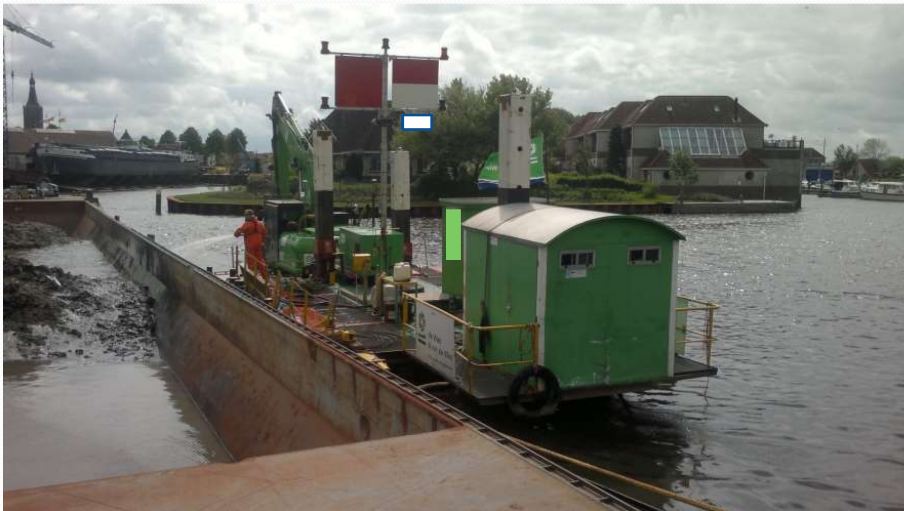
Ponton met baggerkraan
