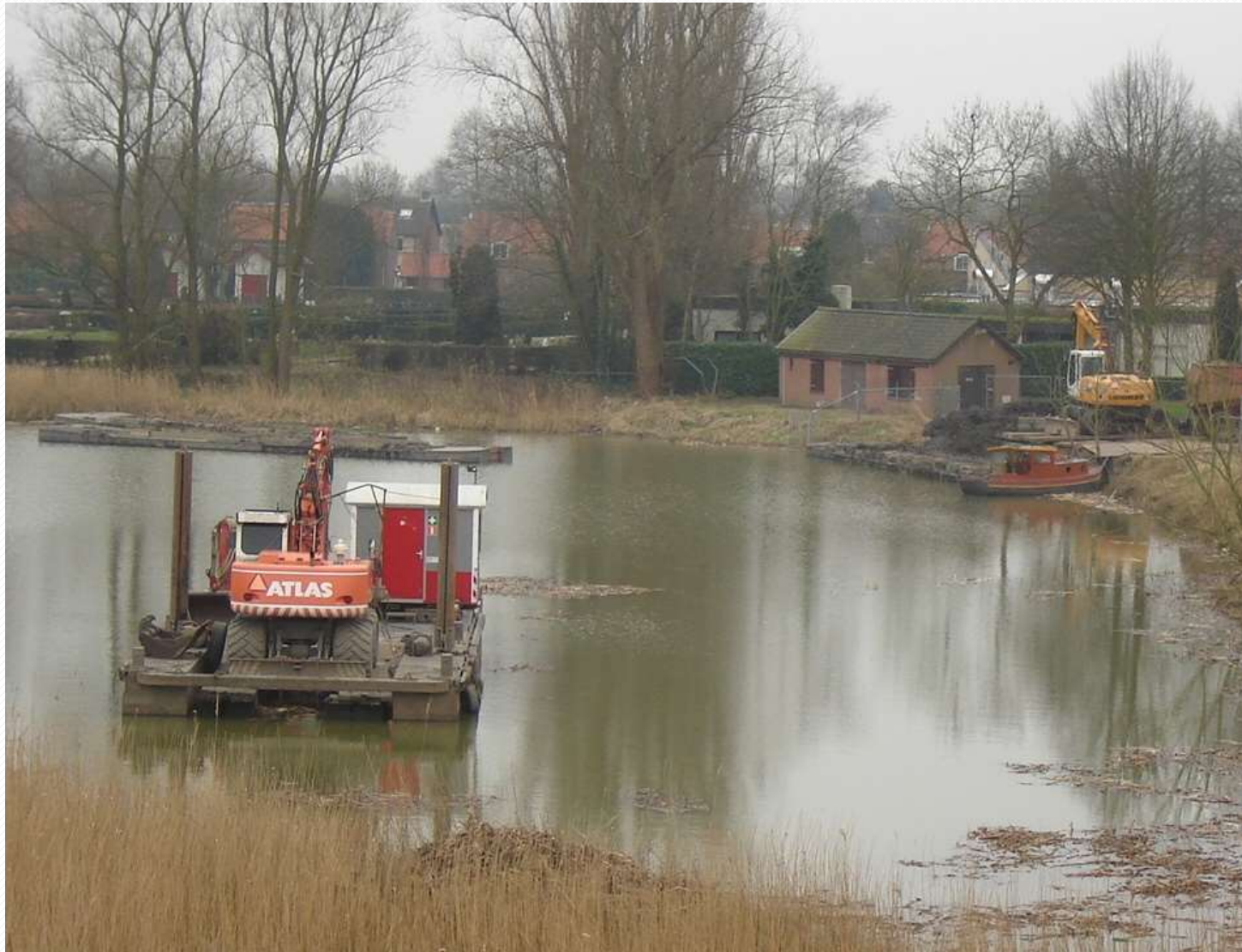
Binnenstedelijk kleinschalig baggerwerk
